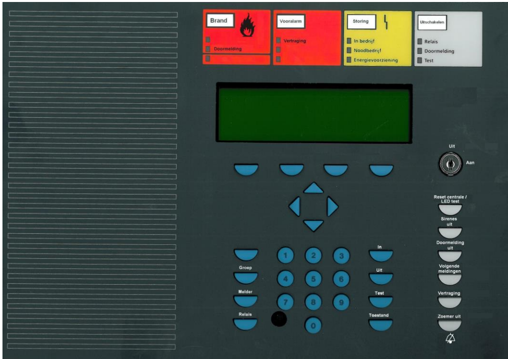
aanzicht bedieningsgedeelte van brandmeldcentrale zonder ontruimingsbediening (type F)
